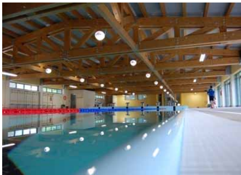
A destra, la visuale dell'ambiente privo di canalizzazioni
