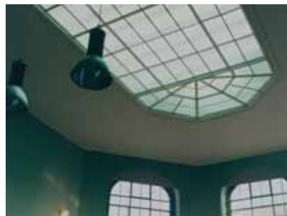
Per questa sala conferenze dell'ospedale di Dresda in Germania è stata utilizzata la lastra Lexan Thermoclear Drippard.
