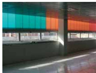
Il sistema di lastre Lexan Thermoclick è usato per la facciata di questo edificio a Barcellona.
