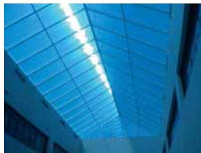
La lastra Lexan Thermoclear Sun XP, con protezione dai raggi UV su entrambi i lati, è utilizzata per il tetto di vetratura di questa scuola ad Al Wasel, UAE Dubai.
