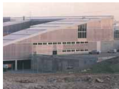
La lastra Lexan Thermoclick è stata scelta dallo studio di architettura Abalos & Herreros per il rivestimento verticale di questo edificio, grazie alle proprietà termoisolanti e di trasmissione della luce elevata.
