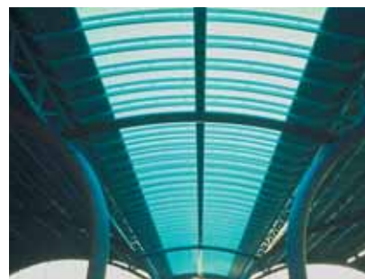
La lastra Lexan Exell D è usata per il tetto dell'entrata di questa stazione della metropolitana di Rotterdam, in Olanda.
