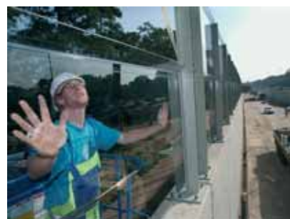
Schermi insonorizzati lungo la linea ferroviaria ad alta velocità di Koker Peerdsbos tra i Paesi Bassi e Anversa
