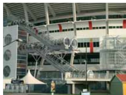
L'Amsterdam Arena ha scelto la lastra Lexan Solar Control IR come materiale per la vetratura dei tunnel delle scale mobili dei quattro lati dello stadio.
