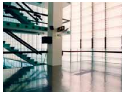
Sistema di lastre corrugate Lexan utilizzato per la facciata e l'interno dell'edificio del teatro di Rotterdam, in Olanda.
