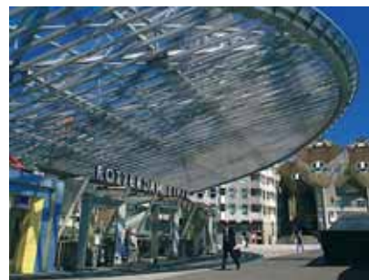
La lastra Lexan Exell D è usata per il tetto dell'entrata di questa stazione della metropolitana di Rotterdam, in Olanda.
